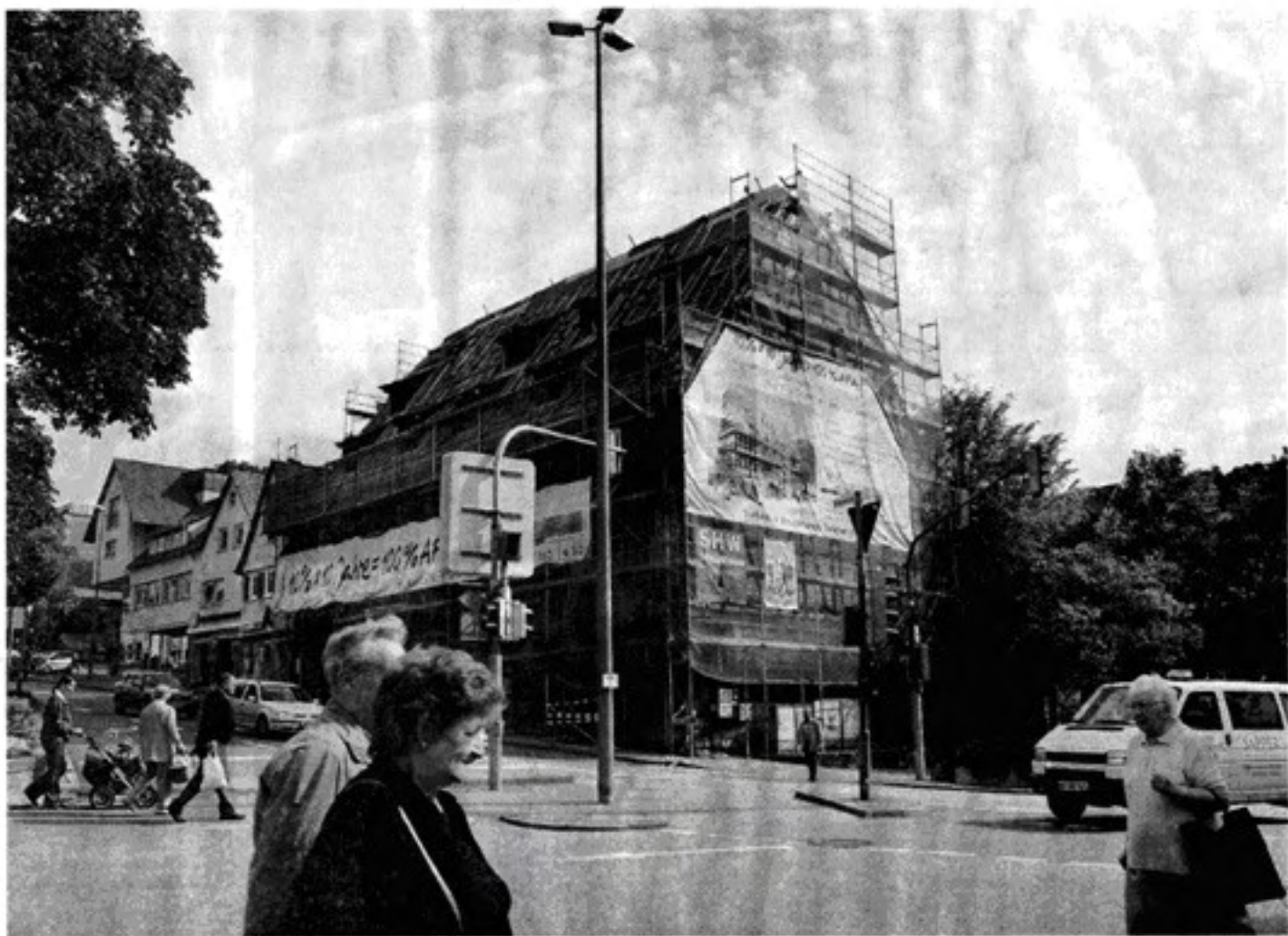
Hinter dem Gerüst wird eine 300 Jahre alte Perle aufpoliert.
