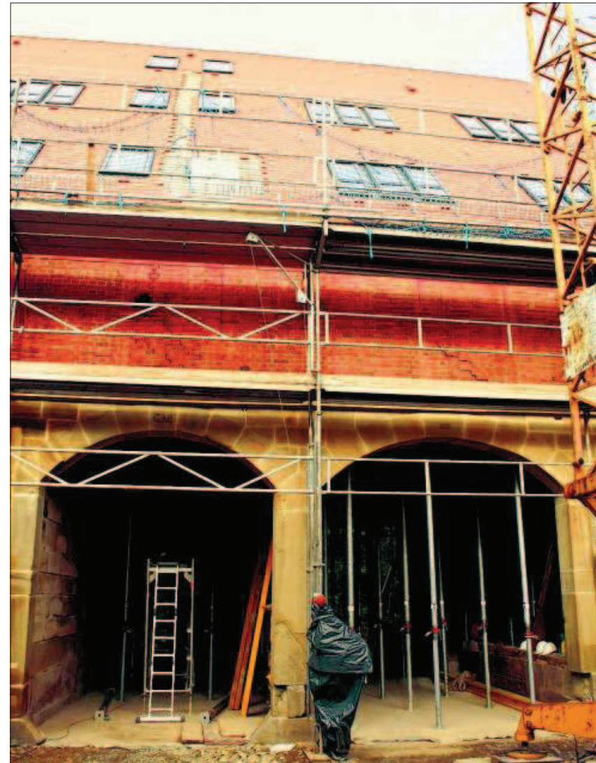
Das im Jahre 1881 von Gustav Maier errichtete Gebäude hat mit 19 Meter Höhe und 16 Meter Breite gewaltige Ausmaße für eine Scheune.
